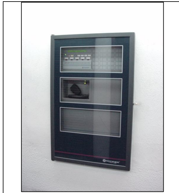
Central de incendio AFP - 400 Sistema de detección y alarma de incendio estandarizado
